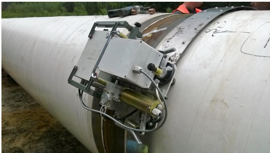
Rys. 7. Zautomatyzowany system DR do badań obwodowych spoin rurociągów zamontowany na rurociągu DN 1000.
